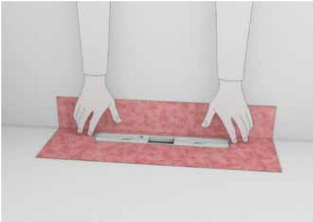
**Step 4:** Sigillato con un clic! Una volta posato il massetto, la prima parte della protezione viene rimossa dal pozzetto e il collare di tenuta, fornito in dotazione, viene inserito mediante il meccanismo a scatto. Ora l'area doccia può essere impermeabilizzata e rivestita.
